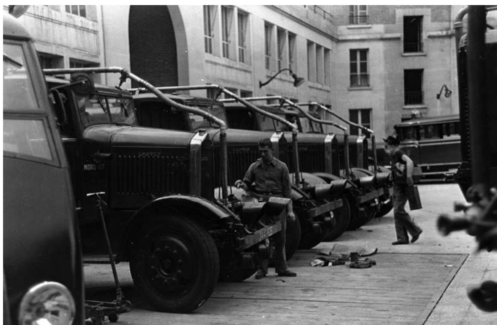
Réglage et vérification des arroseuses Laffly dans la cour de la caserne Champperret, 27 août 1939. © BSPP
