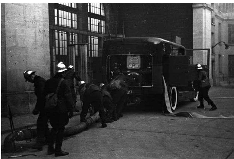
Alimentation du fourgon-pompe à grande puissance ancien modèle (Somua). Cour de la caserne Champerret, 16 mars 1940. © BSPP
