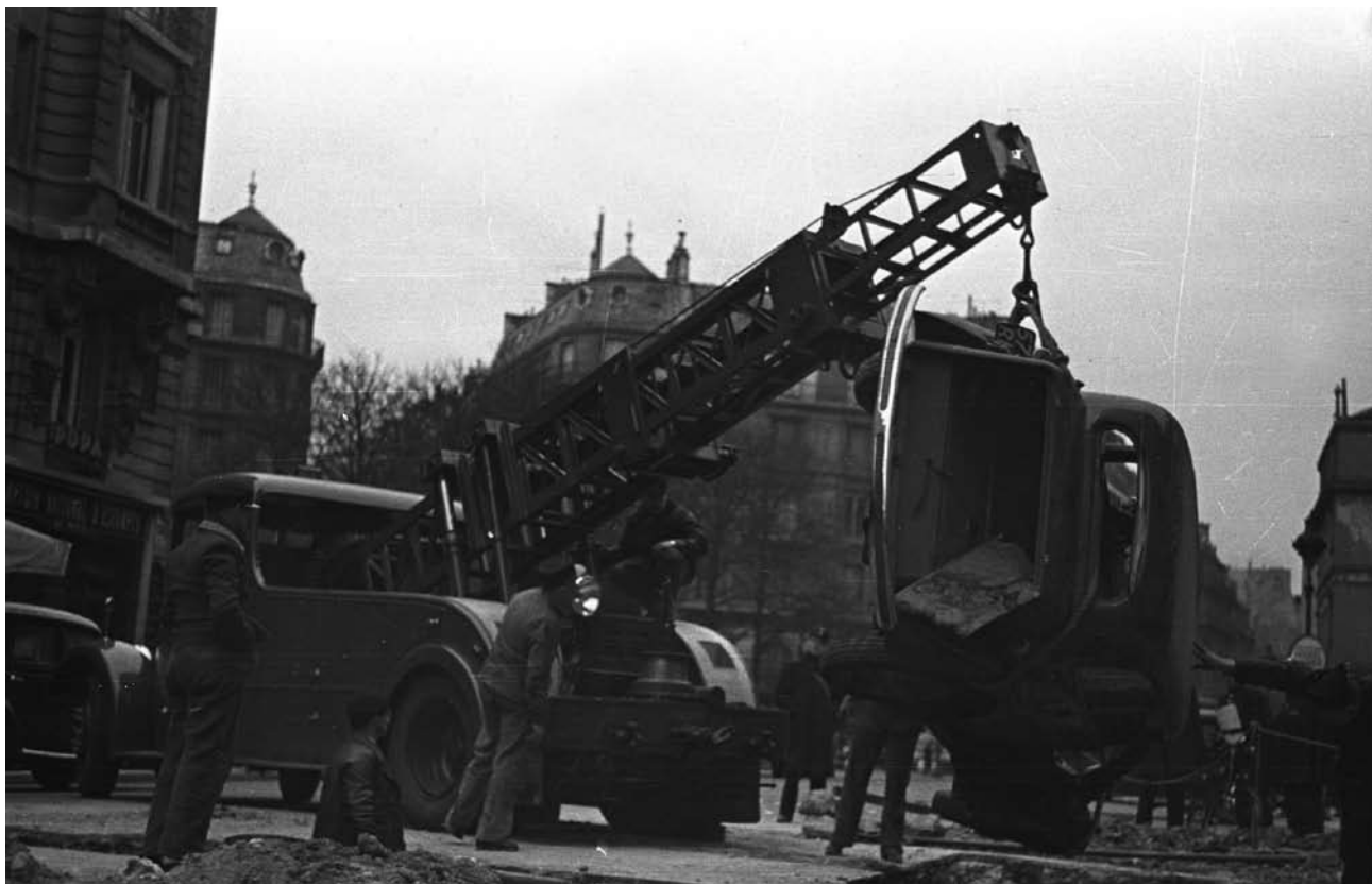
Relevage par camion-grue d'une voiture tombée dans une tranchée. Angle de la rue de La Boétie et de la rue du Faubourg-St-Honoré, 1 er mars 1940. © BSPP
