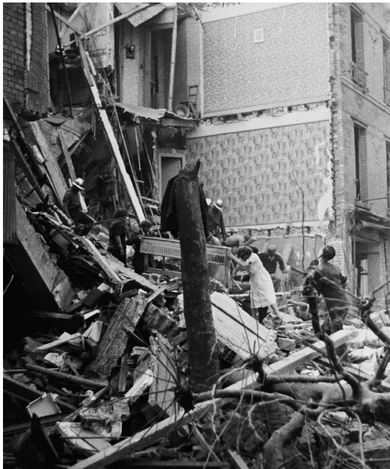
Sapeurs-pompiers procédant à des recherches dans les ruines d'un immeuble. Suresnes, avril 1943. © BSPP
