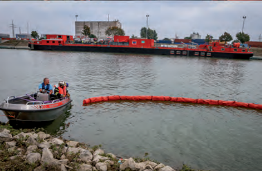
Pose de barrage Ausbreitung einer Sperre
