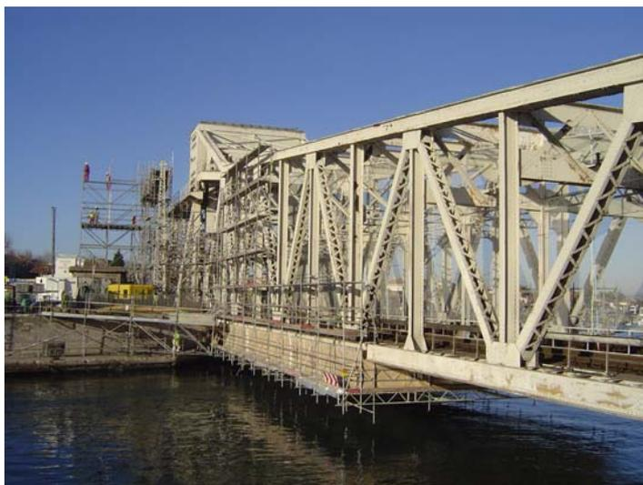
A partir du 11 janvier le pont ferroviaire Maréchal Foch sera immobilisé en position basse afin de réaliser l'ensemble des travaux de remise en peinture nécessaire à l'entretien de l'ouvrage.
