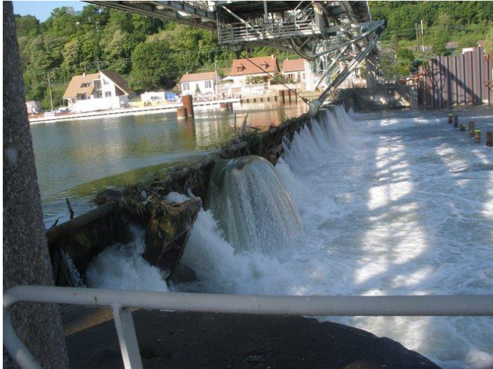
Barrage de l'Écluse du Coudray (91) Crédit photo : Nicole V.
